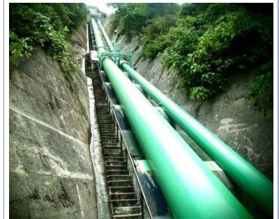
富山県・上市川第三発電所水圧鉄管点検橋修繕工事
