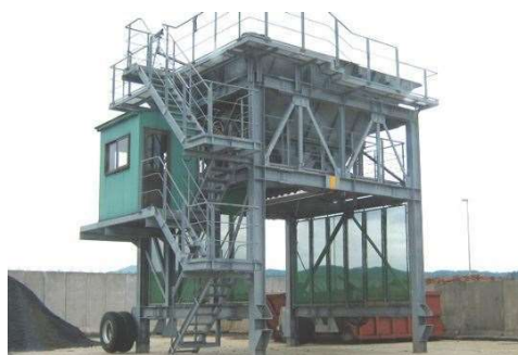
(出所) 伏木海陸運送 HP より引用
