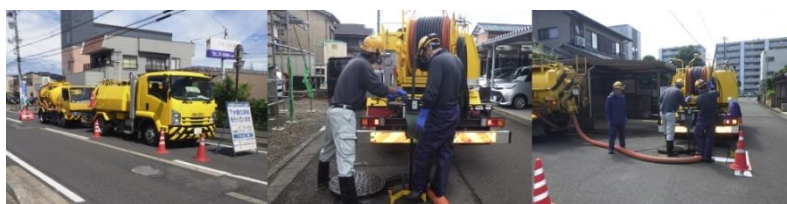
下水管の調査・清掃
