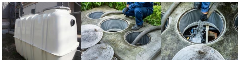
専用の清掃車で浄化槽を清掃
