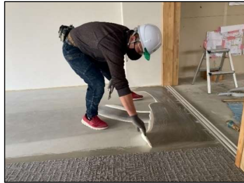
4. <OA フロア工事>
