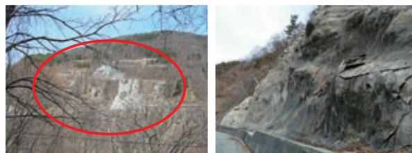
図2 長野県伊那市の南アルプス林道の法面に写る山体の重力変形
