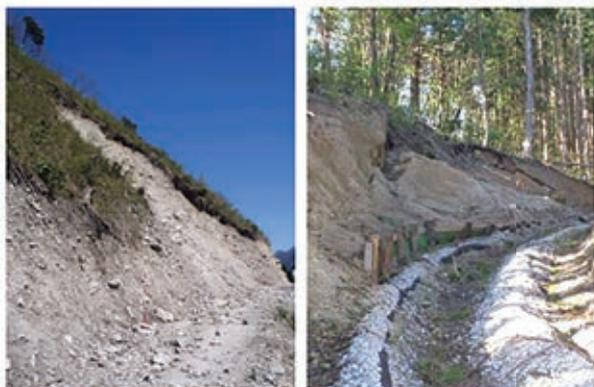
図1 建設後の数年間で急速に劣化が進む森林作業道の例
