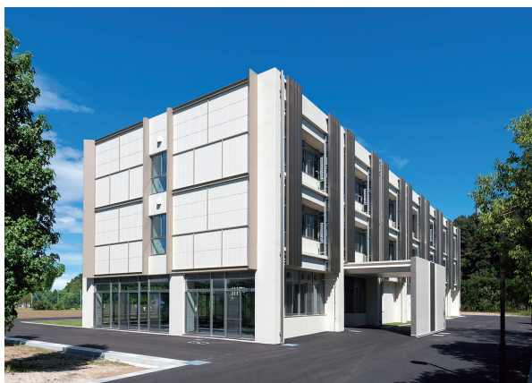
図2 富山大学 軽金属材料共同研究棟 Plant Zero
