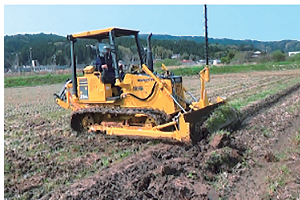
ICTブルドーザーによる圃場整備
