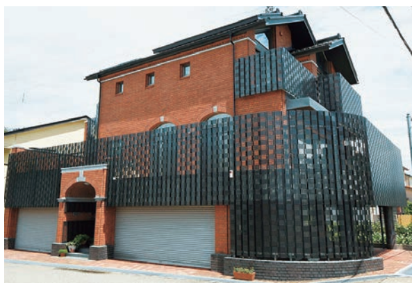
建物の外装材としてデザインされた市松文様の有孔折板
