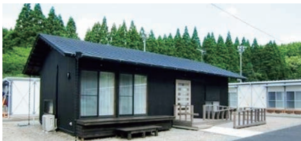
入居者の孤立を防ぎ、コミュニティづくりを促進するため、各仮設団地内に整備された「みんなの家」。
