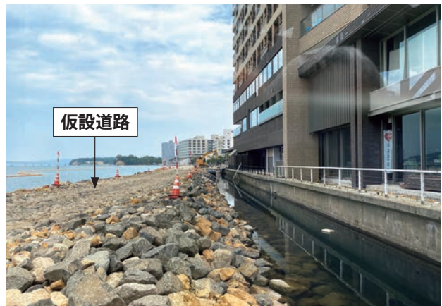
図6 重機通行のために整備された仮設道路
