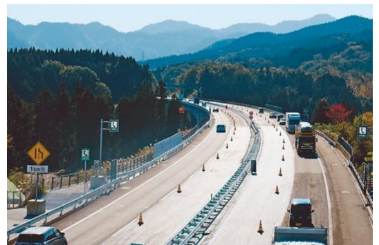
全線4車線化向け工事が進む東海北陸自動車道＝南砺市立野原東（城端）
